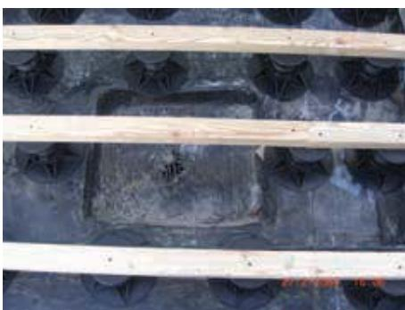
Il est toujours possible de changer le sens de pose des lames en modifiant la disposition des lambourdes en-dessous.
