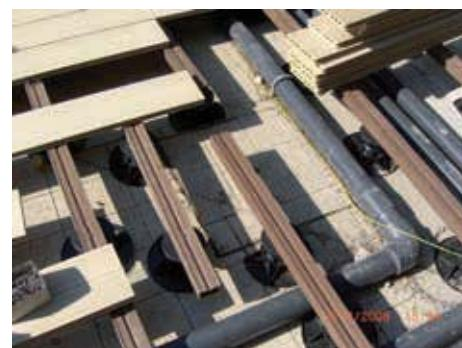
*Se puede siempre cambiar el sentido de la puesta de los listones modificando la disposición de los travesaños colocados debajo.*
